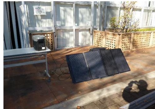
ソーラーパネル付き蓄電池（ソーラーパネルによる充電中）
